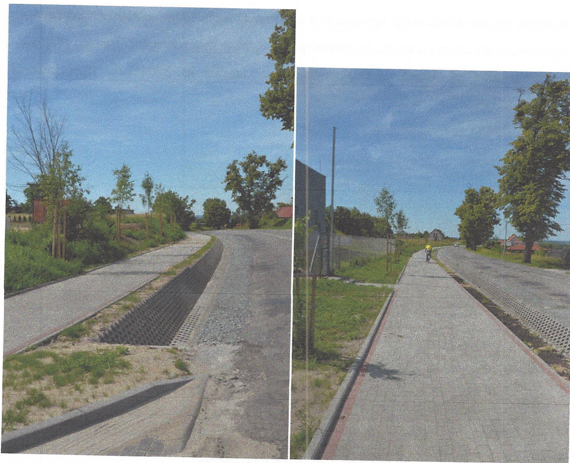
Źródło: zdjęcie z zasobów Urzędu Gminy Kwidzyn przedstawiające inwestycję – budowa ciągu pieszo-rowerowego w Rozpędzinach
