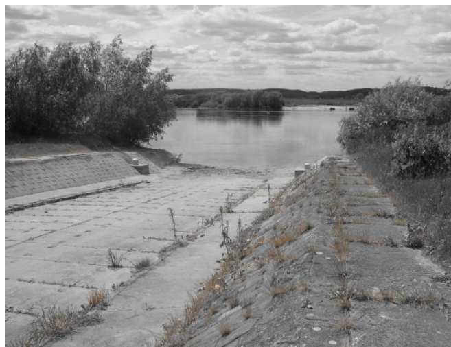
Fot.4 Widok na zjazd dawnego promu
