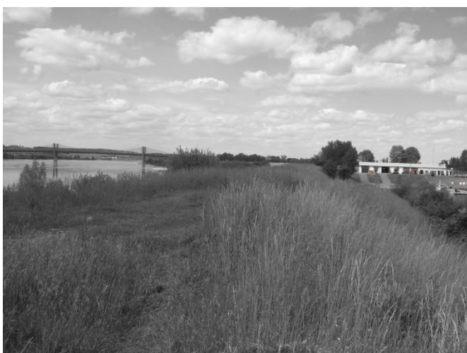
Fot.3 Lokalizacja inwestycji przy wale przeciwpowodziowym pomiędzy korytem Wisły a basenem portowym.
