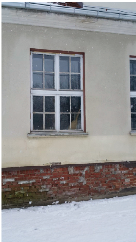
Widok cokołu – brak tynku. Drewniana stolarka okienna.
