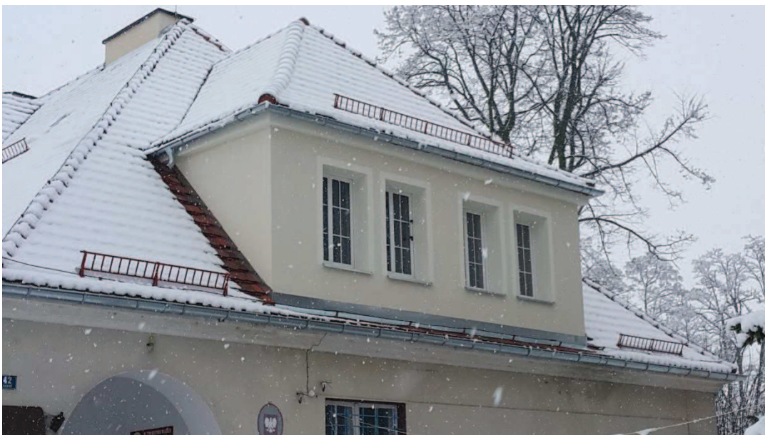
Widok lukarny – po przeprowadzonej termomodernizacji – strona szczytowa – prawa.
