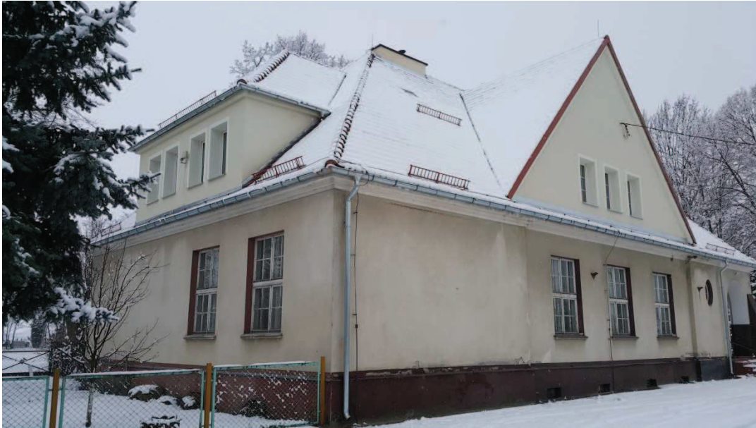
Widok budynku od strony szkoły. Ściany lukarny od strony szczytowej – lewej oraz wykusza od strony frontowej po termomodernizacji.
