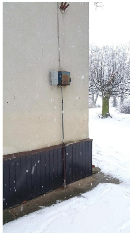
Widok cokołu obłożonego płytami PCV.
