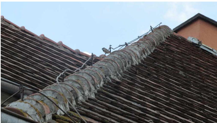
Widok gąsiorów i instalacji odgromowej.
