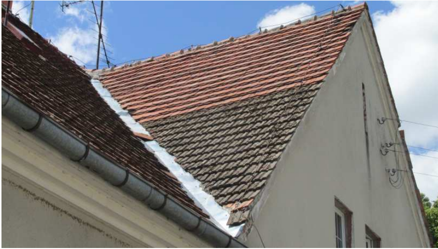
Widok fragmentu pokrycia dachówką cementową.
