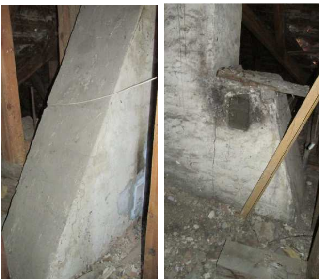
Widok części trapezowych komina.
