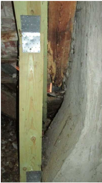
Widok zniszczonej krokwi przy kominie nr 4
